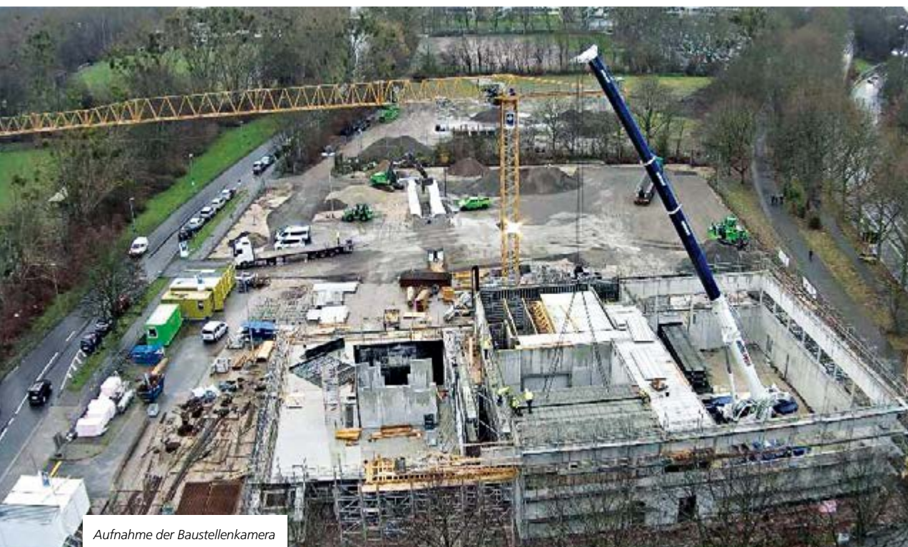
Montage der Pi-Platten
