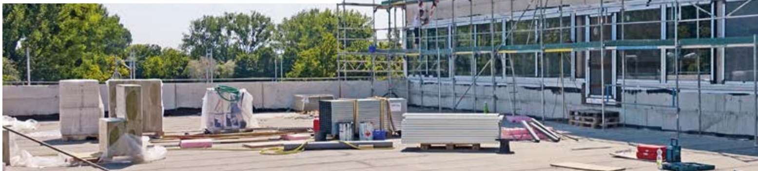
Malarbeiten mit dem Hubwagen in der Sporthalle
